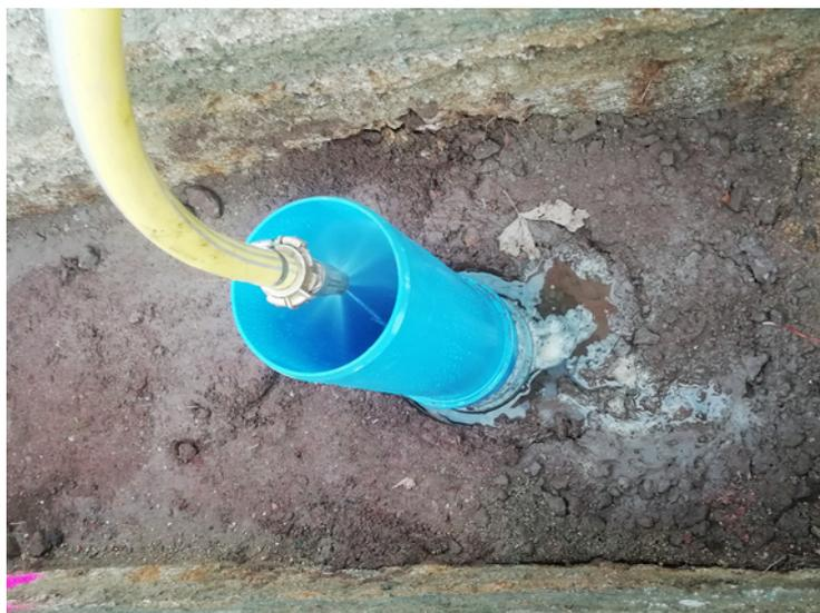
Abbildung 3: Bewässerung des Grabens über das Belüftungsrohr mit gedrosselter Wasserabgabe, um eine oberflächliche Verteilung des Wassers zu vermeiden.
